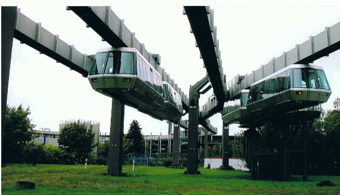
Fahrtrasse: links regulärer Fahrweg für Personenbeförderung, rechts Abzweig zur Betriebswerkstatt
